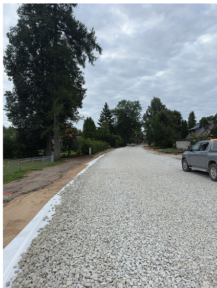
Killustikaluse ehitus enne asfalteerimistööd.
