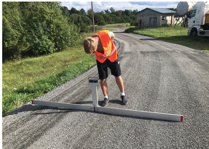
Sipa-Kütke tee ülevaatus. Lääne Teed OÜ objektijuht Indrek Rajamets kontrollib tee kallet.
