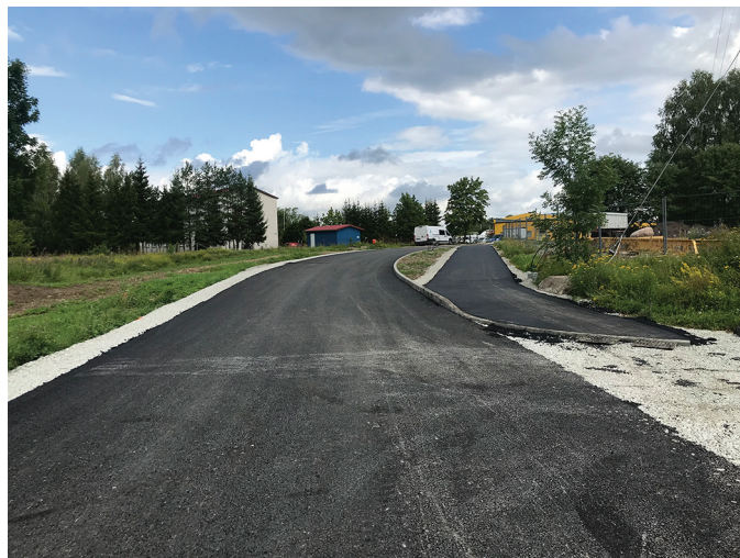
28. juulil pandi Välja tänavale ja kergliiklusteele maha alumine asfaltkate.
